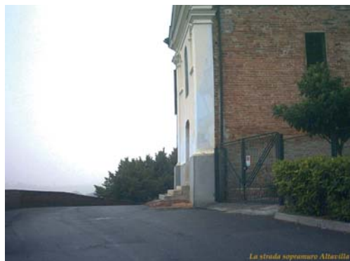
La strada sopra mura Altavilla
