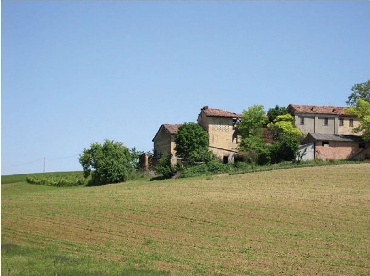
Casorzo: casolari abbandonati.
