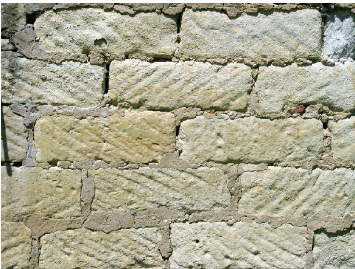
Fig. 25 – Casorzo: vecchio muro perimetrale realizzato in tufo locale.
